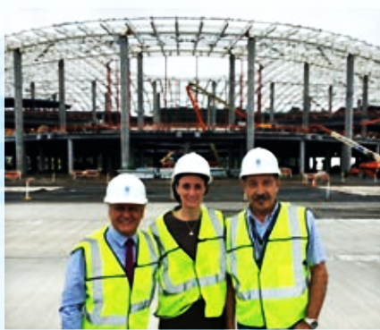
Visita del Embajador Miguel Torres del Sel a las obras de ampliación de la terminal 2 del Aeropuerto Internacional de Tocumen. El Recorrido fue guiado por el Gerente de Construcción de la fiscalización, el Arquitecto y Master en Sistemas Aeroportuarios, el argentino D. Fernando Ratto.
